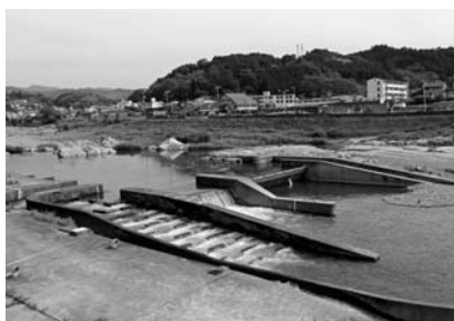
▶ 下流域頭首工と魚道
